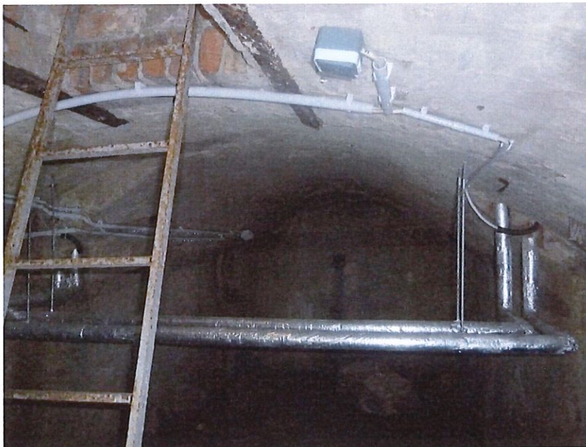
Ansicht Tonnengewölbe über Gruftvorraum mit Einstiegsöffnung
